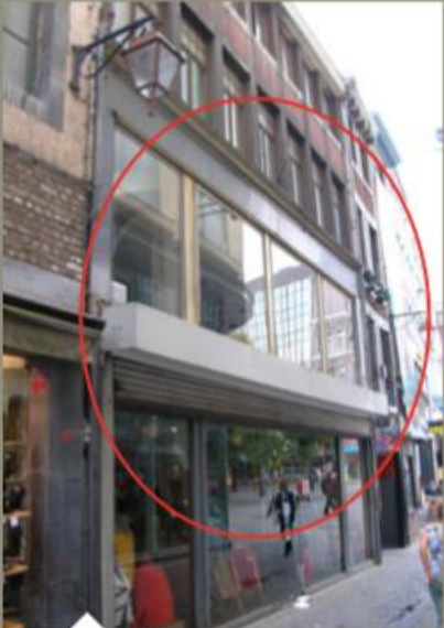
MAUVAIS : Architecture d'origine éventrée sur deux niveaux, caisson de volet apparent
